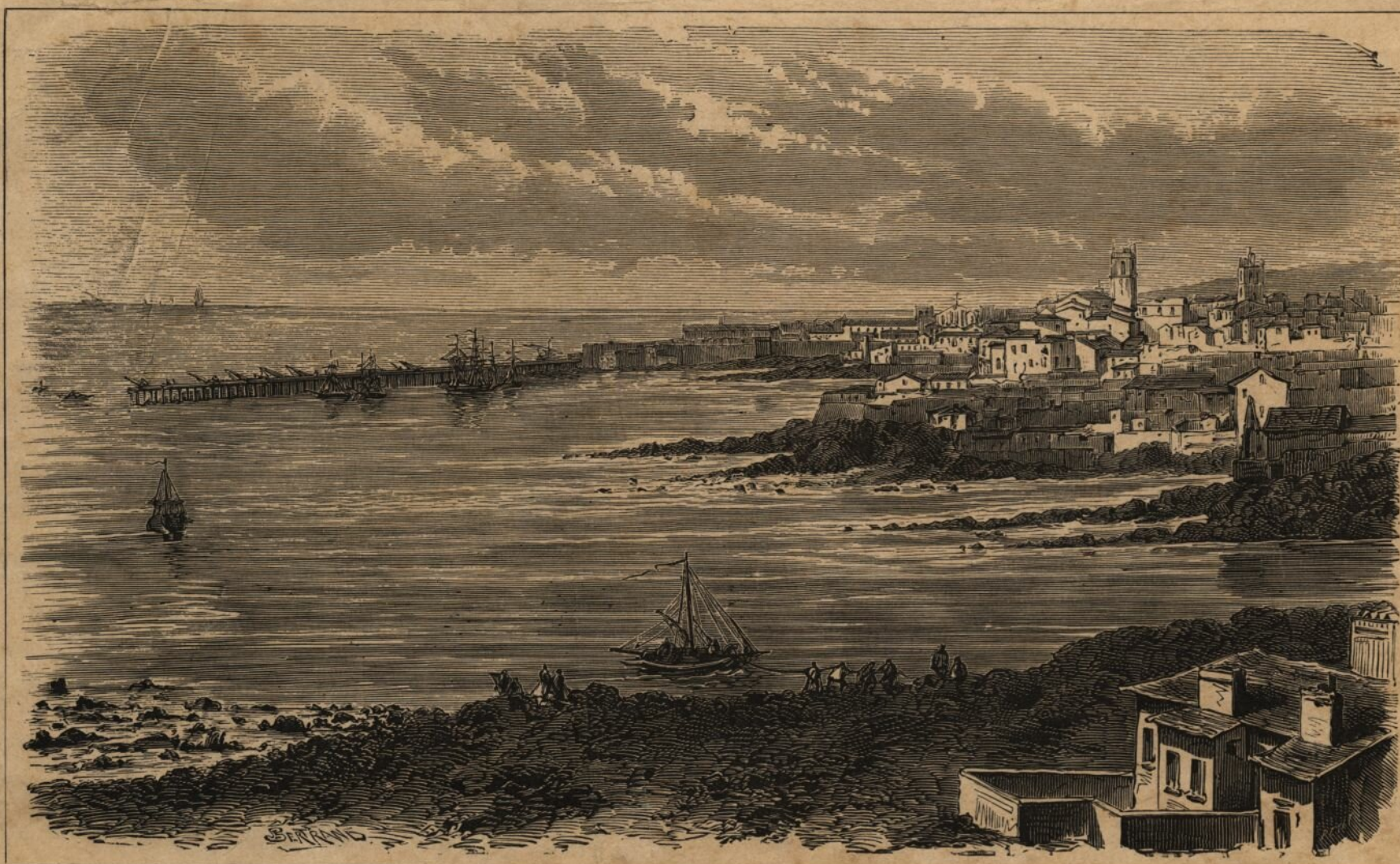
Vue du brise-lame en construction en face de Ponta Delgada, prise le 16 décembre 1866.
