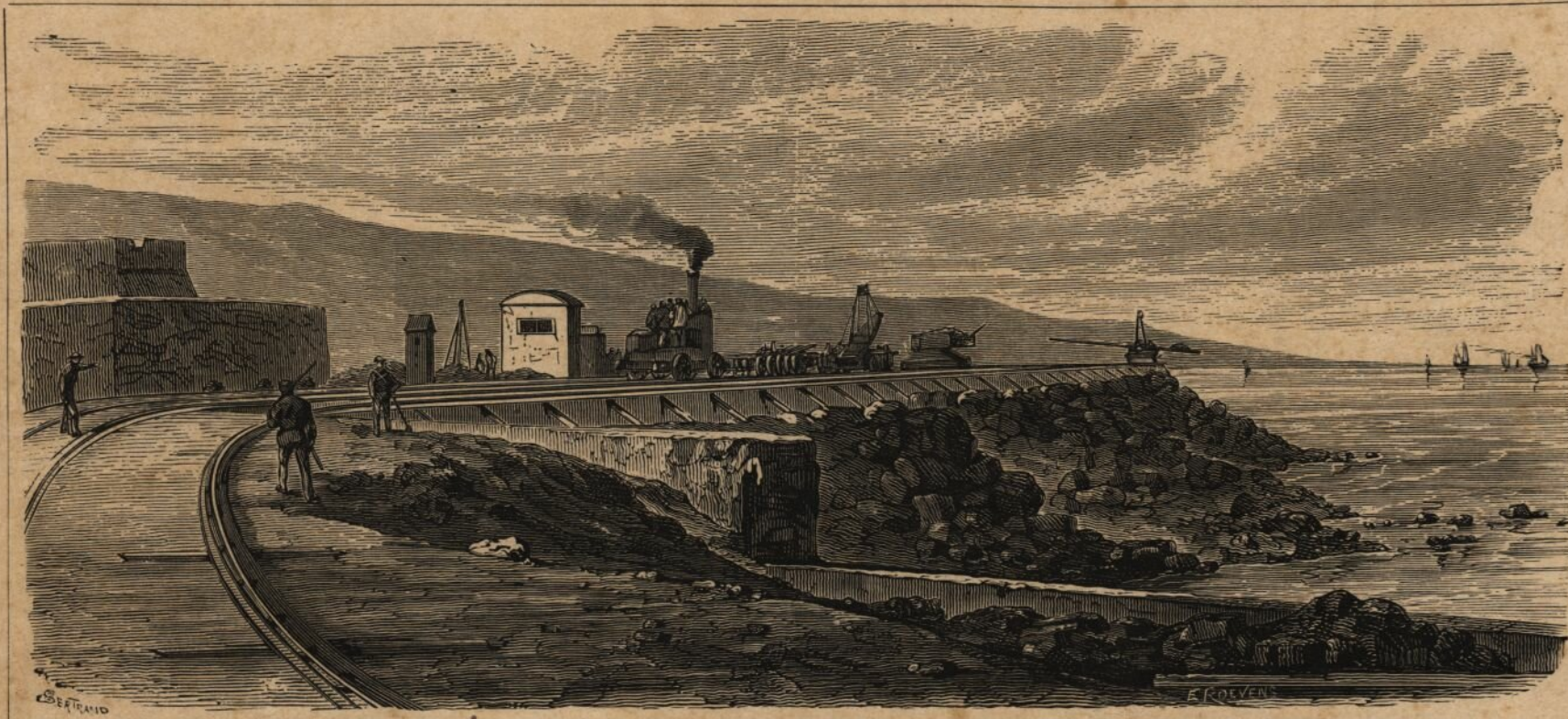
MOYENS EMPLOYÉS POUR LA CONSTRUCTION DU BRISE-LAME.
