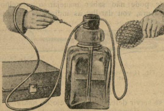
Fig. 43 — Aparelho de pirogravura, servindo para o dourado florentino
