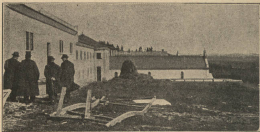
Edifícios da Secretaria, Padaria, Oficinas, Moagem a vapor e antiga capela
