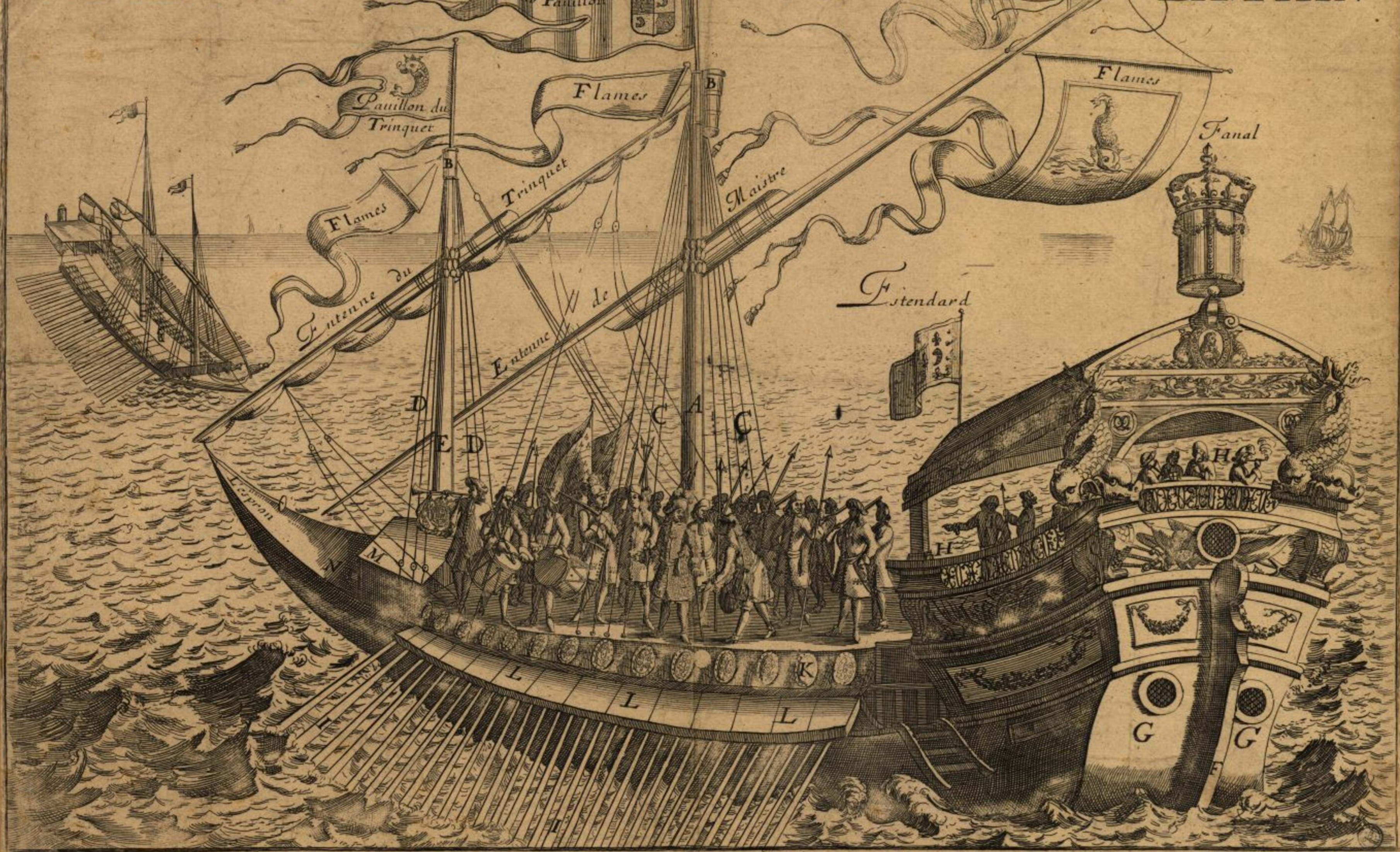
A-Grand Mast ou Arbre de Maistre, B-le Calcat, C-les 5 Coustiers, D-les 3 Coustiers, E-Mast du Trinquet, F-le Timon, G-la Chambre du Capitaine, H-la Poupe, I-les Rames, K-Le Fougou ou lieu ou est la cuisine, L-les Bancs ou sont assis les Forcats, M-l'esbar, N-Piece ou Canon de Coursier. Se vendent A Paris chez IOLLAIN, rue S. Jacques a la porte de la Vierge, 1682. 86
