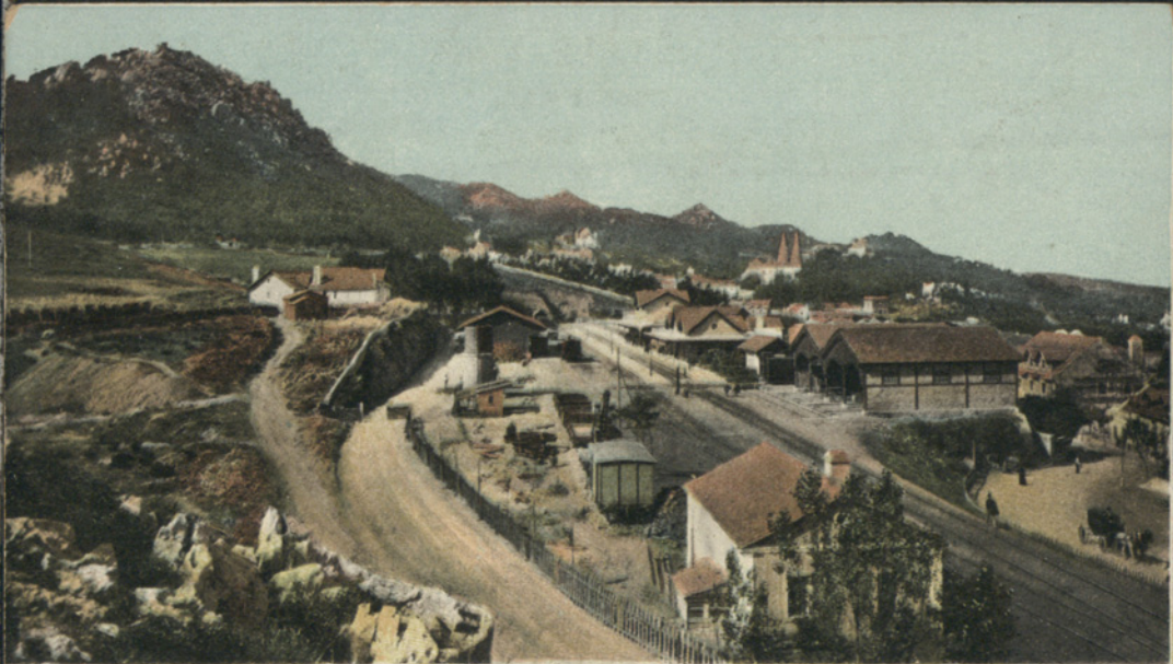
CINTRA (Portugal). Gate e vista parcial
