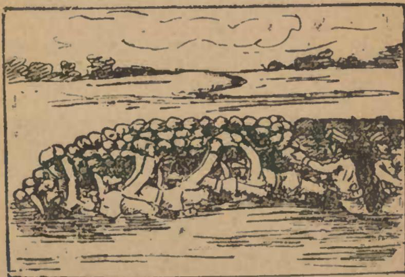
Fig. 40 —Prolongamento duma trincheira com sacos de terra
